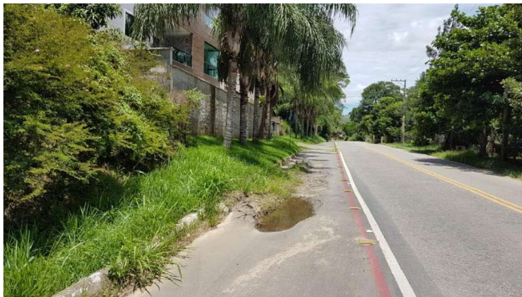
Figura 71 – Trecho Degradado da Ciclofaixa na RJ-115
