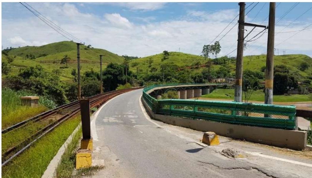
Figura 21 – Ponte em Pare e Siga para Barão de Juparanã
