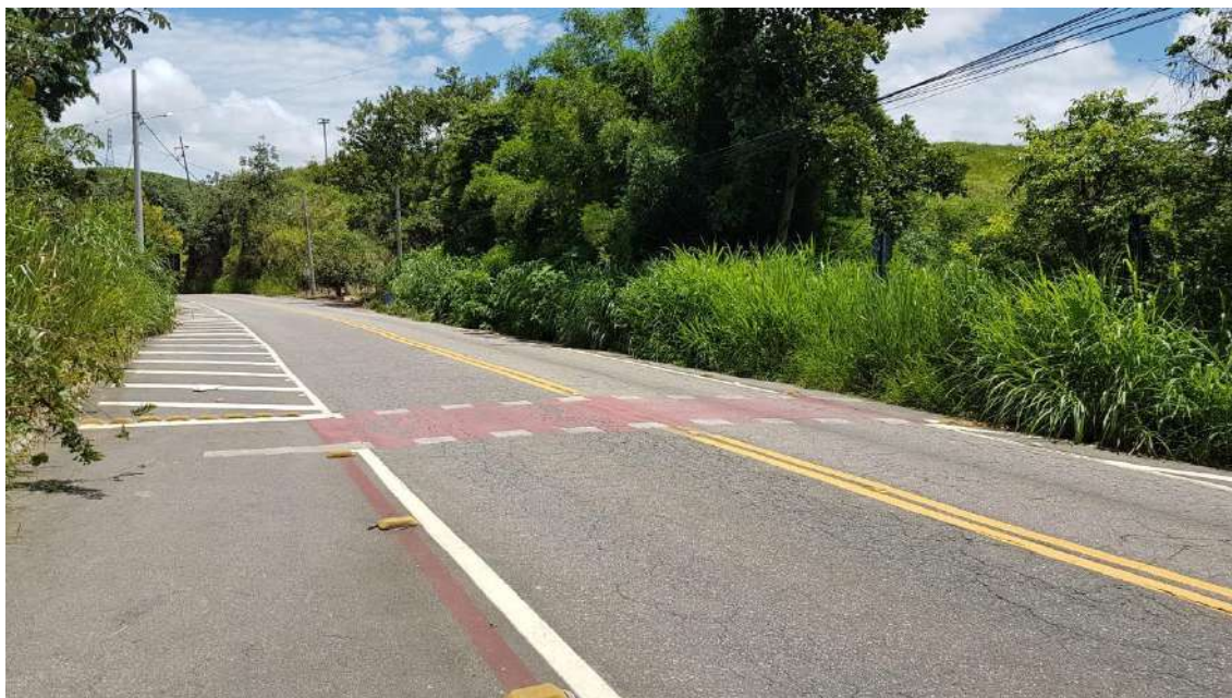
Figura 73 – Travessia da Ciclofaixa na RJ-115
