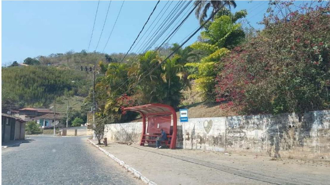
Figura 83 – Ponto de Parada de Ônibus sem Rampa de Acesso
