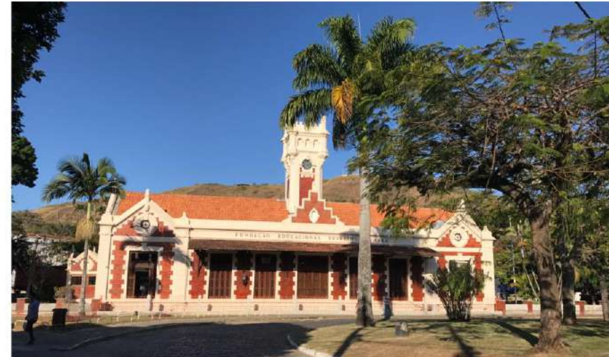
Figura 48: Antiga Estação, atual presidência da USS. Fonte: Keilla Miranda 2017.
