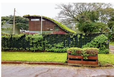
Teto jardim e muro vegetado (Ecotelhado).
