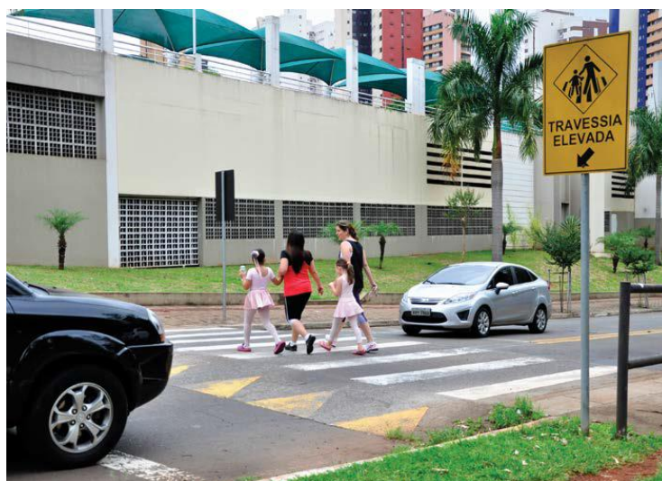
Figura 29. Exemplo de Faixa de travessia elevada em Londrina, PR
