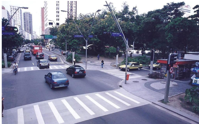
Figura 28. Exemplo de rebaixamento de calçada no Rio de Janeiro
