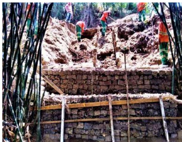
**Construção de muro de arrimo Rodovia RJ 115 em decorrência de deslizamento setembro 2020**
